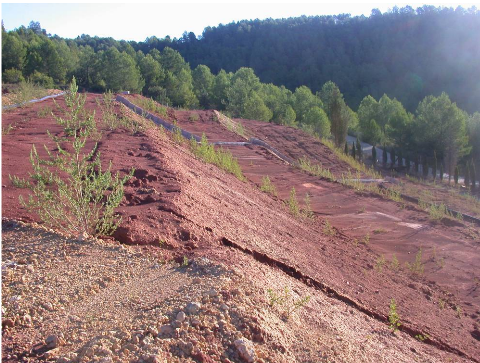
Entrada del vertedero y detalle de las bermas
