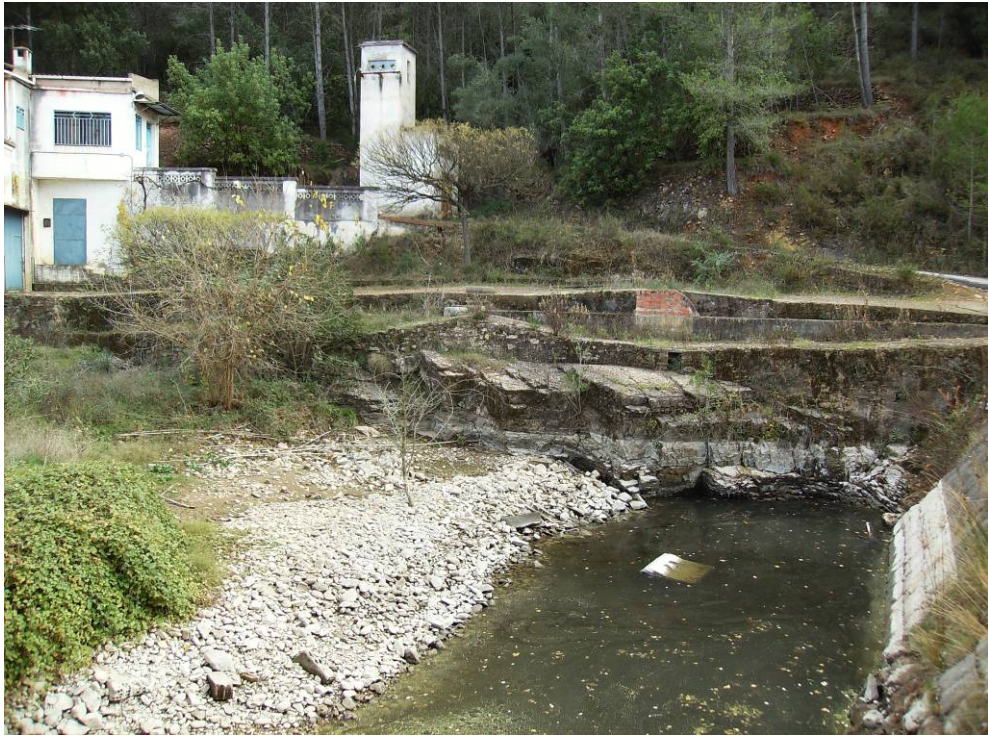
Zona de vertido sobre las calizas y dolomías del Muschelkalk y junto al pozo San Isidro
