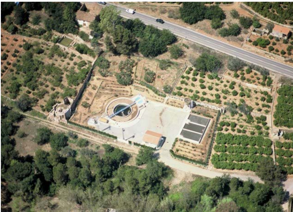
Foto 2. Imagen de la EDAR de Tales y Sueras (fotografía perteneciente a EPSAR)
