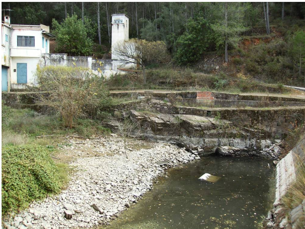
Fotos 3 y 4. Imágenes panorámicas del punto de vertido
