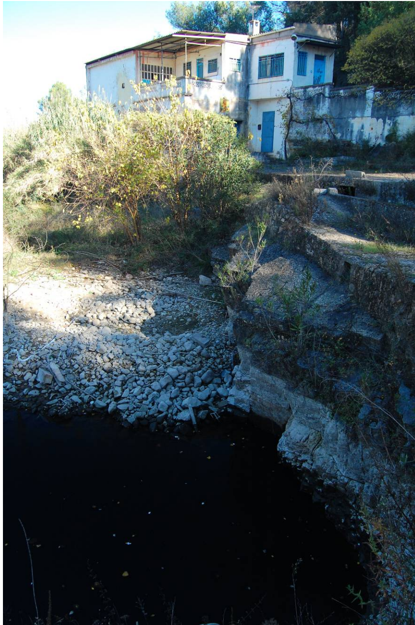
Foto 10. Detalle del área de vertido. Se observa el afloramiento de las calizas del Muschelkalk, el escaso recubrimiento de bolos y gravas y la proximidad del sondeo San Isidro (Nº ref.7, nº IGME 29253001)
