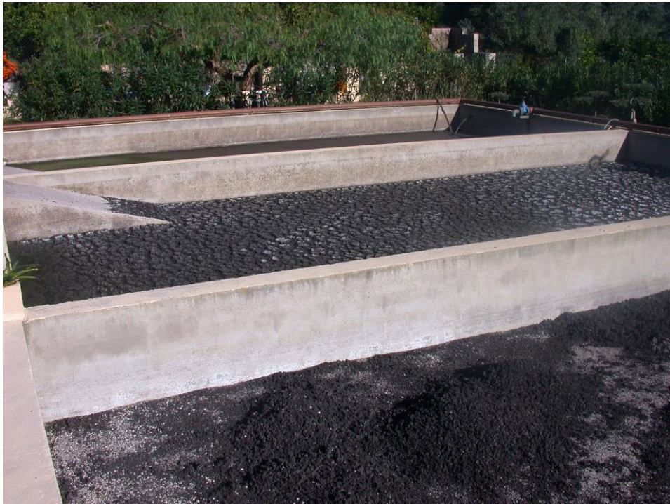
Detalles de las fases de depuración
